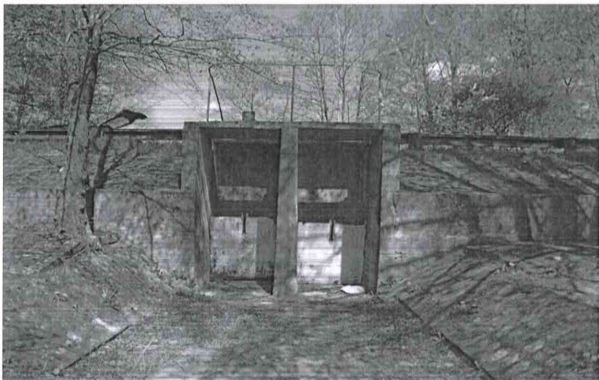
Przepust 2 x D:100 cm pomiędzy jez. Suszewskim i jez. Kownackim; dno od WG ok. 98,20 m n.p.m. ; od WD ok. 98,05 m n.p.m.
