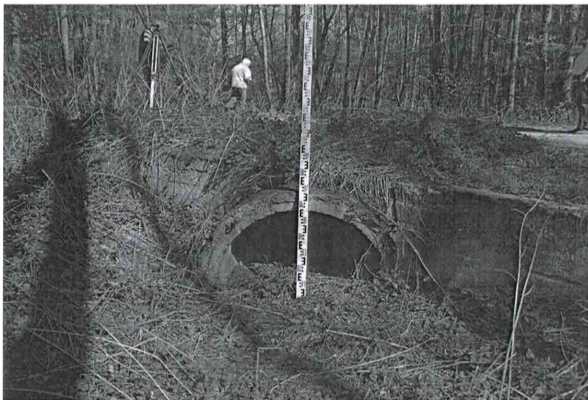
Przepust D:100 cm na cieku łączącym jez. Budzislawskie z jez. Suszewskim; dno od WG ok. 99,16 m n.p.m.; od WD ok. 98,52 m n.p.m.
